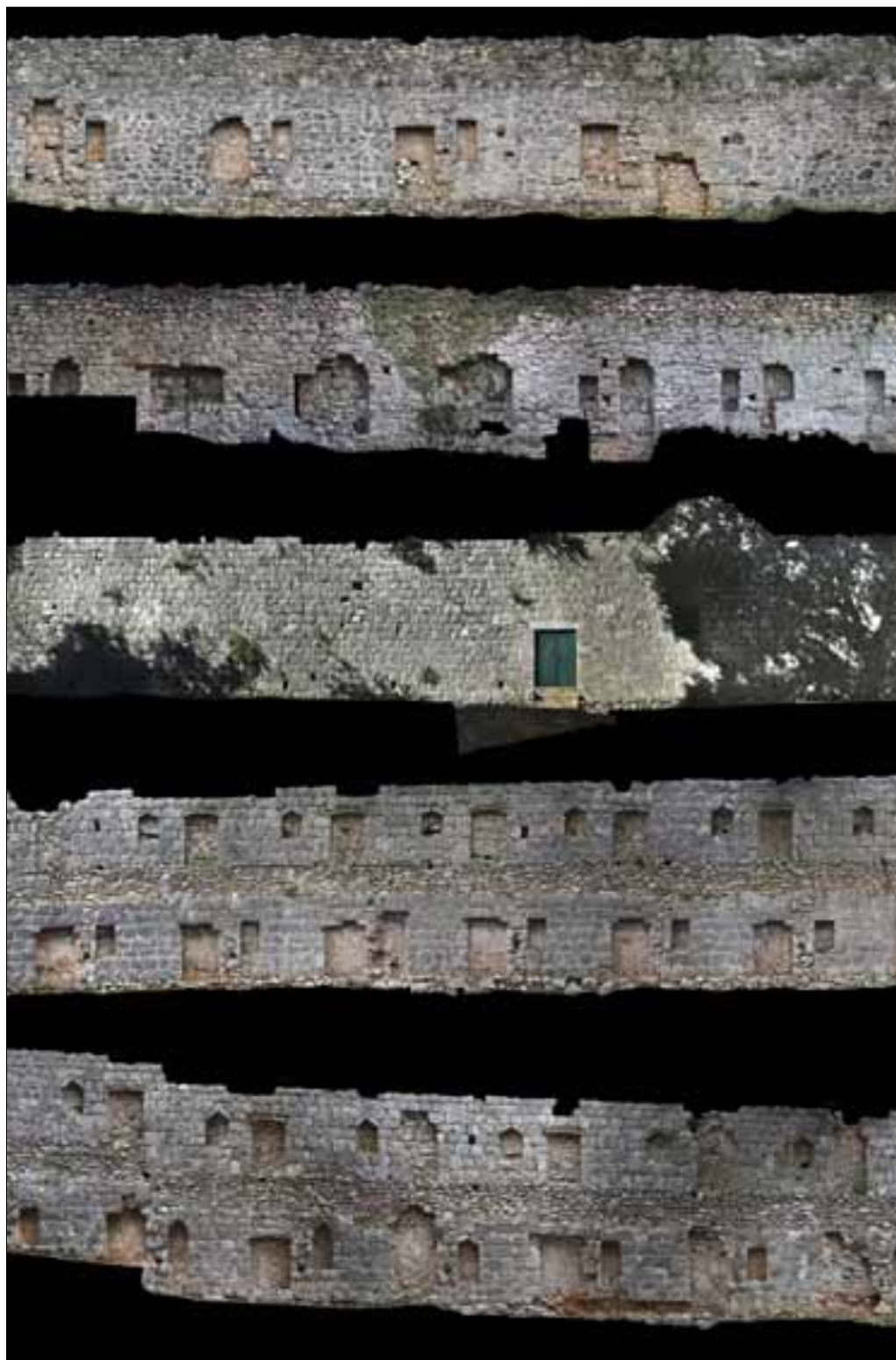
Slika 23. Detalji zidnih struktura lazareta na Lokrumu:
