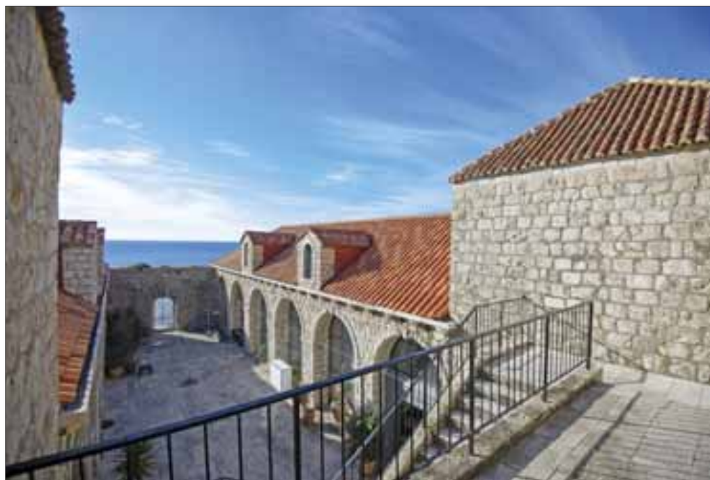
Slika 11. Ostakljene arkade u Lazaretima (fotografija: Zavod za obnovu Dubrovnika)
