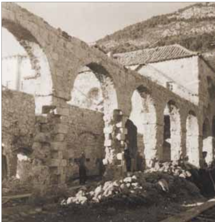
Slika 18. Lazareti tijekom obnove, 1967.-1969. godine
